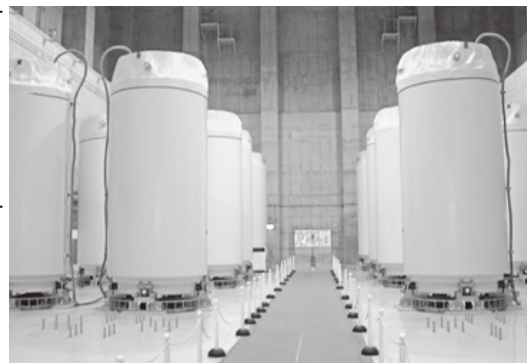
日本で2カ所の原発で行なわれている東海第二原発の少量の乾式貯蔵。
